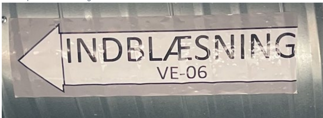
Figur 1 Eksempel på opmærkning af indblæsningskanal for VE06.
